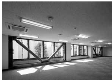
各階にブレースと耐震壁が設置された
