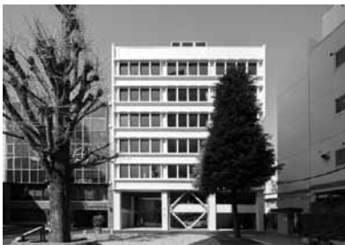
耐震強化ブレースのいった一階
